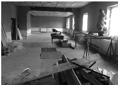
Natahování izolace a omítky.
