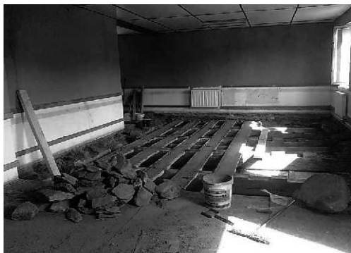
Po odkrytí lina a prken (izolace kamení a suť).
