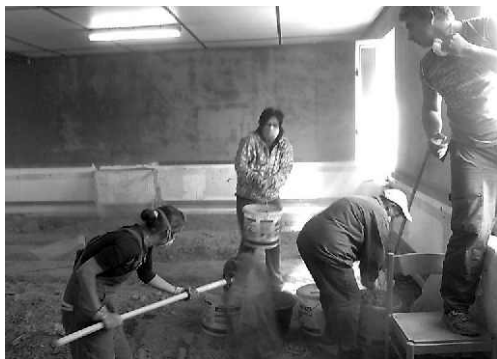
Odklízení suťe obecními pracovníky!
